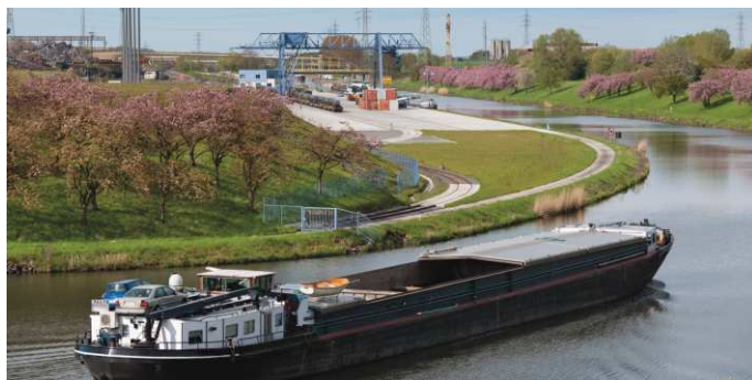
Terminal multimodal de Garocentre
