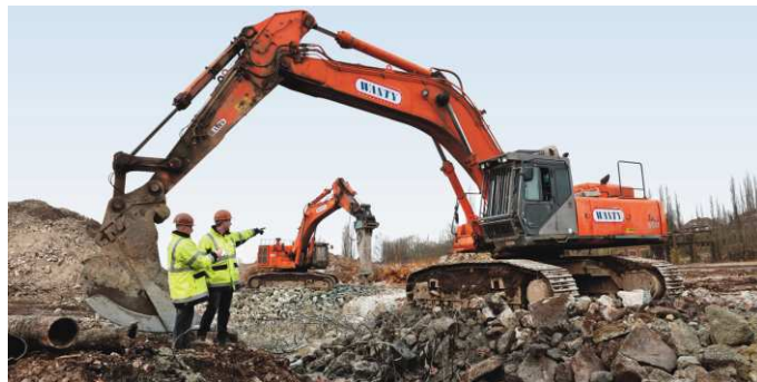
Chantier site des Forges Clabecq
