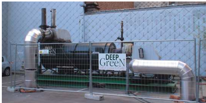
Thermopile© - Dépollution in-situ
