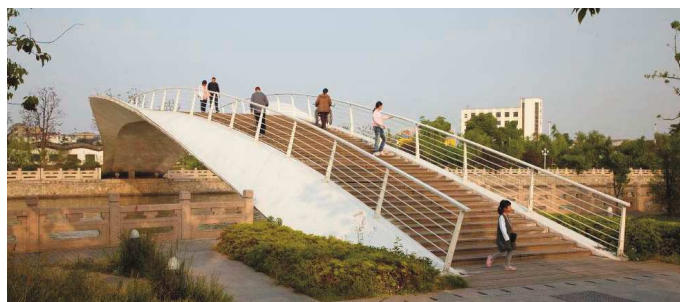
Passerelle piétonne, Yangzhou, Chine - Marc Mimram, 2010
