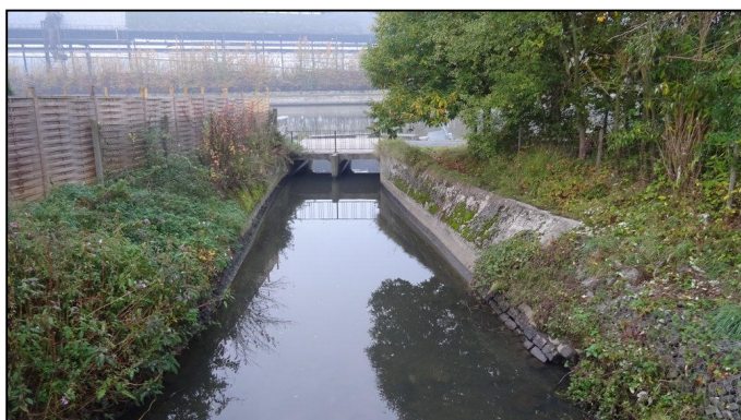
Exutoire du Canal - AVANT
