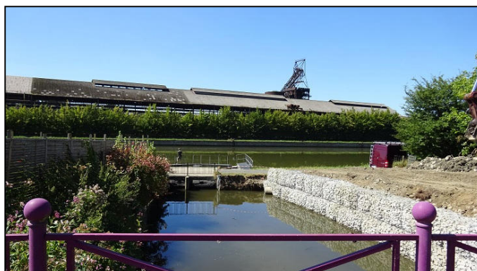
Exutoire du Canal - APRES
