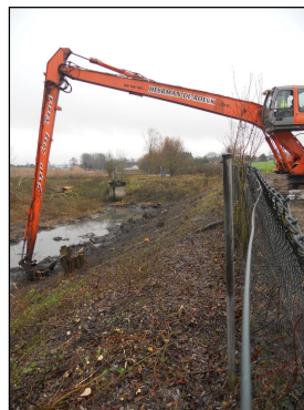
Travaux de grande ampleur pris en charge par l'I.B.W.
