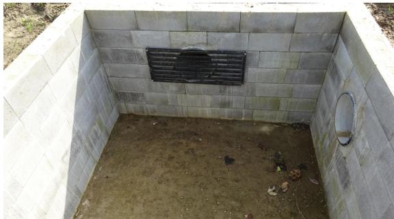
La Brigade Prévention Inondations (Service des Travaux de Tubize) a donc réalisé un bassin d'orage au point bas. Les eaux boueuses sont récoltées via un fossé et dirigées vers ce bassin de décantation.
